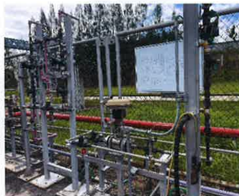
รูปที่ 3-62 อุปกรณ์ป้องกันก๊าซไหลกลับในท่อ (Check Valve)
