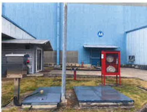
รูปที่ 3-11 ถังบำบัดน้ำเสียสำเร็จรูป
