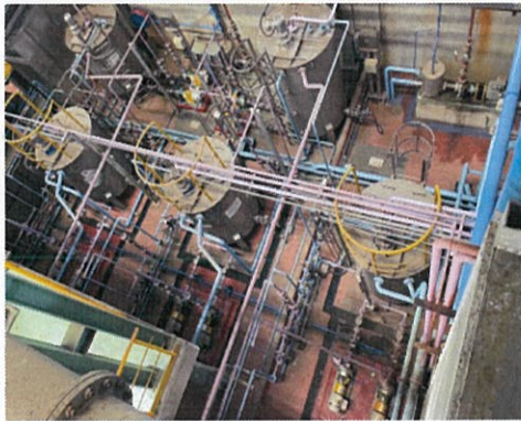
รูปที่ 3-27 บ่อรวบรวมสารละลายโครเมียม จากกระบวนการเคลือบผิว
