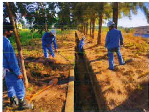
รูปที่ 3-19 การขุดลอกรางระบายน้ำ
